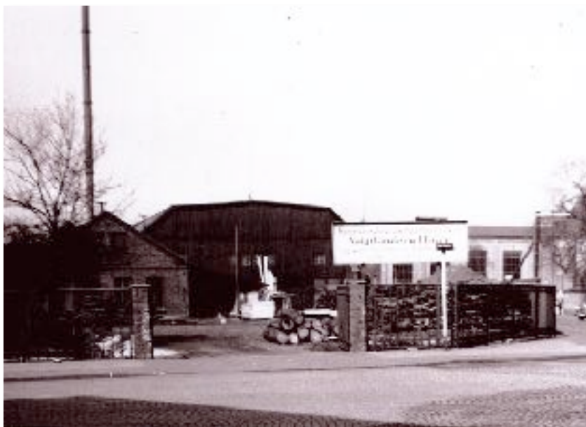
Einfahrt zur Hannoverschen Grubenholzindustrie. Im Vordergrund das Firmenschild, dahinter das Sägehaus und links das Dampfmaschinen-Haus mit hohem Schornstein. (Quelle: Gerd E. Schug)
