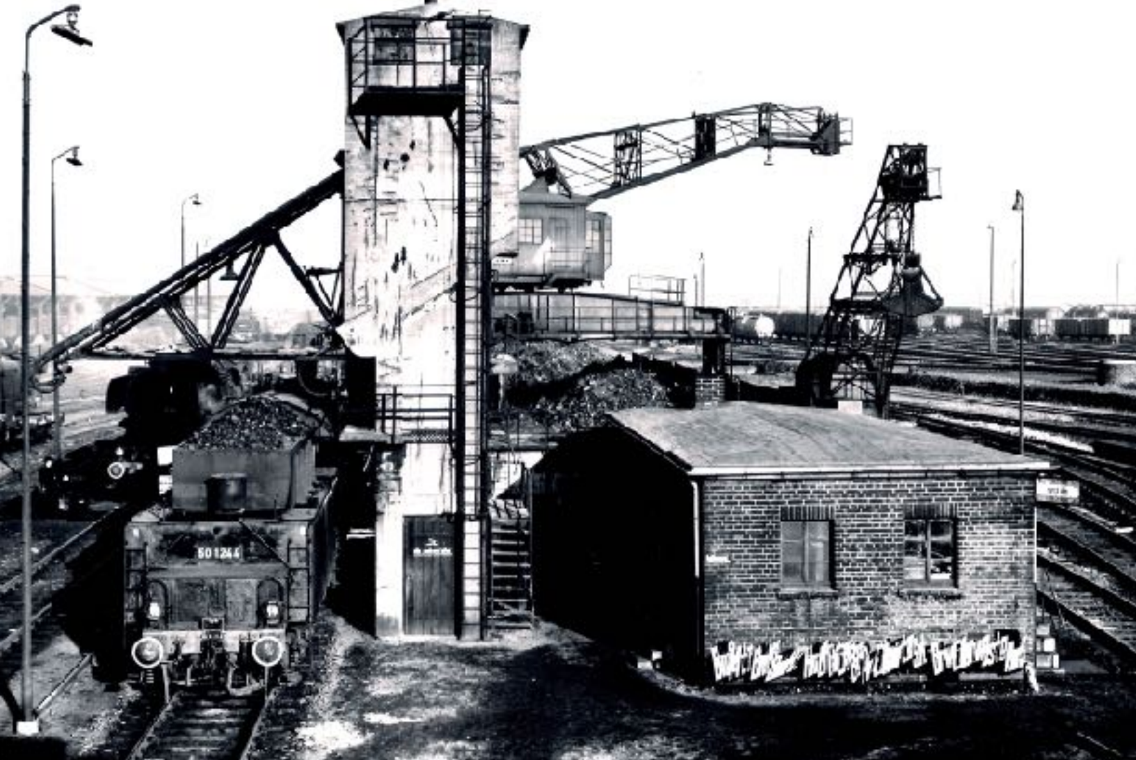
Blick vom Stellwerk Nwt II in Richtung Osten auf den Besandungsturm vorn und dahinter den Kohlenbansen mit Beladungskränen. Links, im Hintergrund, ist das Dach der großen Stückgut-Umladehalle zu erkennen.
